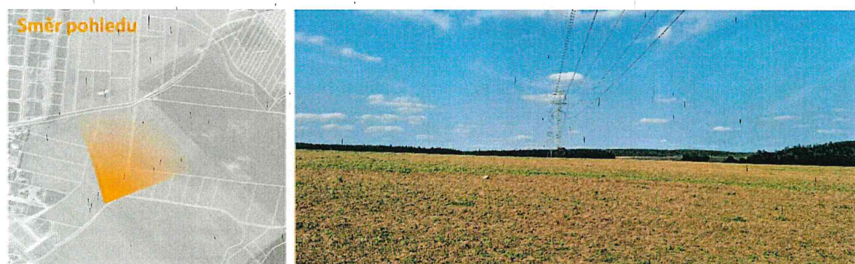
Obr. č. 2 - Pohled na p.č. 1228/29 – směrem na Kladno
